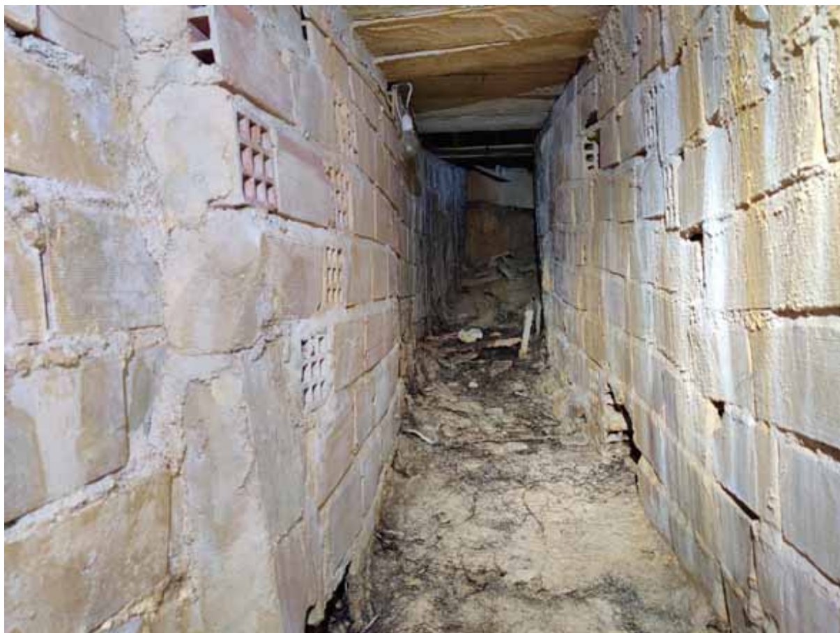
Final de la bifurcación izquierda de la galería (D. Sánchez Garrido, diciembre 2020)
