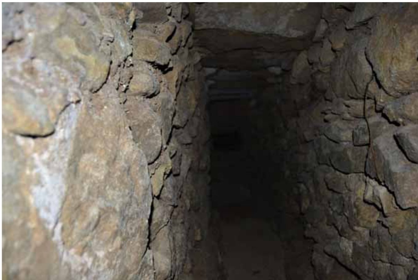
Aspecto de una de las galerías que conducen el agua de los manantiales a la fuente y el abrevadero. (C. Ramírez Perea, noviembre 2019)
