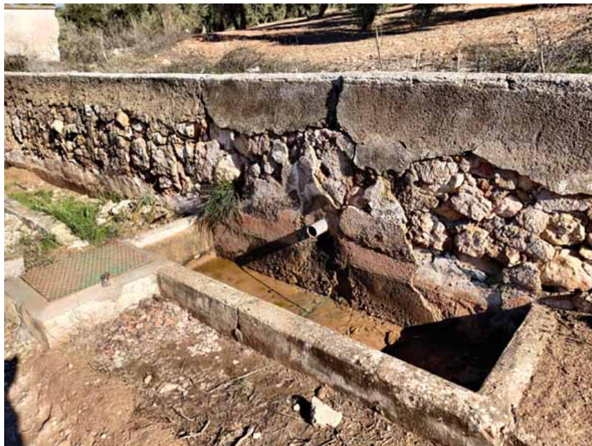
Pilar de Ríez, cuya agua procede del manantial Pozo de Ríez (D. Sánchez Garrido, enero 2021)
