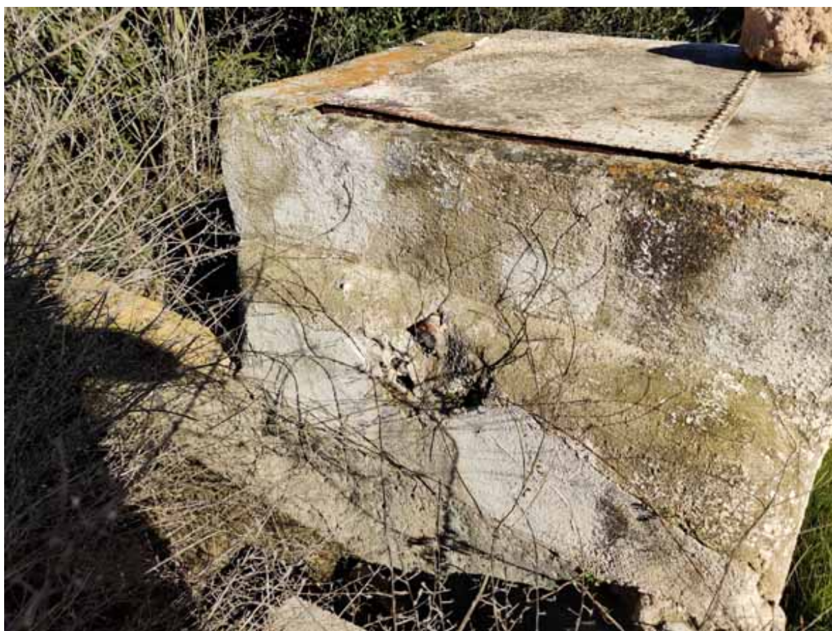
Detalle de la arqueta, donde se observa la boca cegada donde se alojaba el grifo que daba agua a las pilas (D. Sánchez Garrido, enero 2021)
