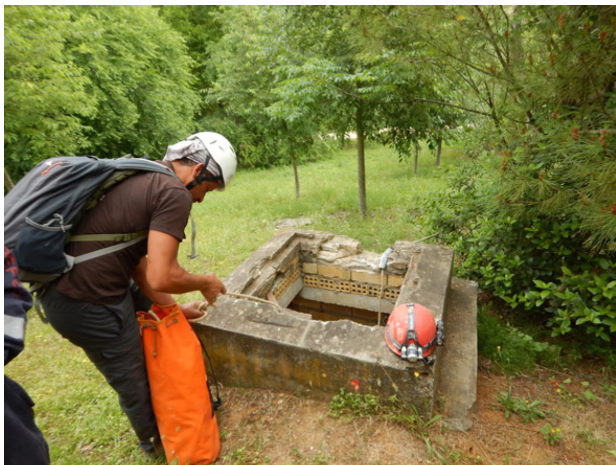
Lumbrera con un brocal de ladrillo y mortero usada como una de las entradas de prospección (J. Millán Naranjo, marzo 2018)
