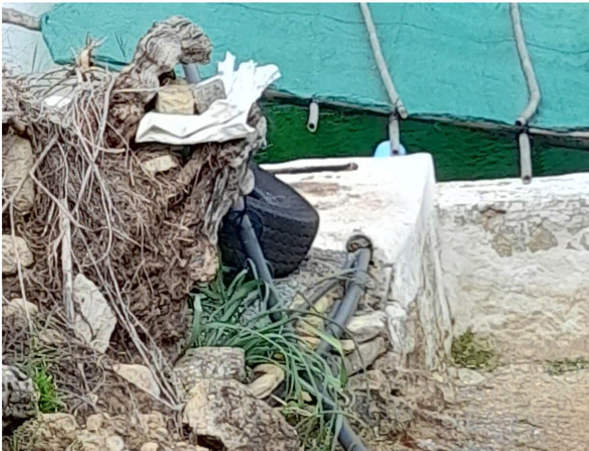
Detalle ampliado de la entrada de la conducción de agua a la alberca (A. Jiménez, abril 2021)
