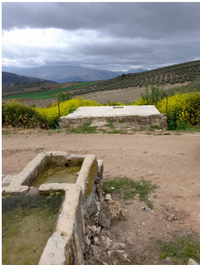
Depósito al otro lado del camino (A. Jiménez, abril 2021)
