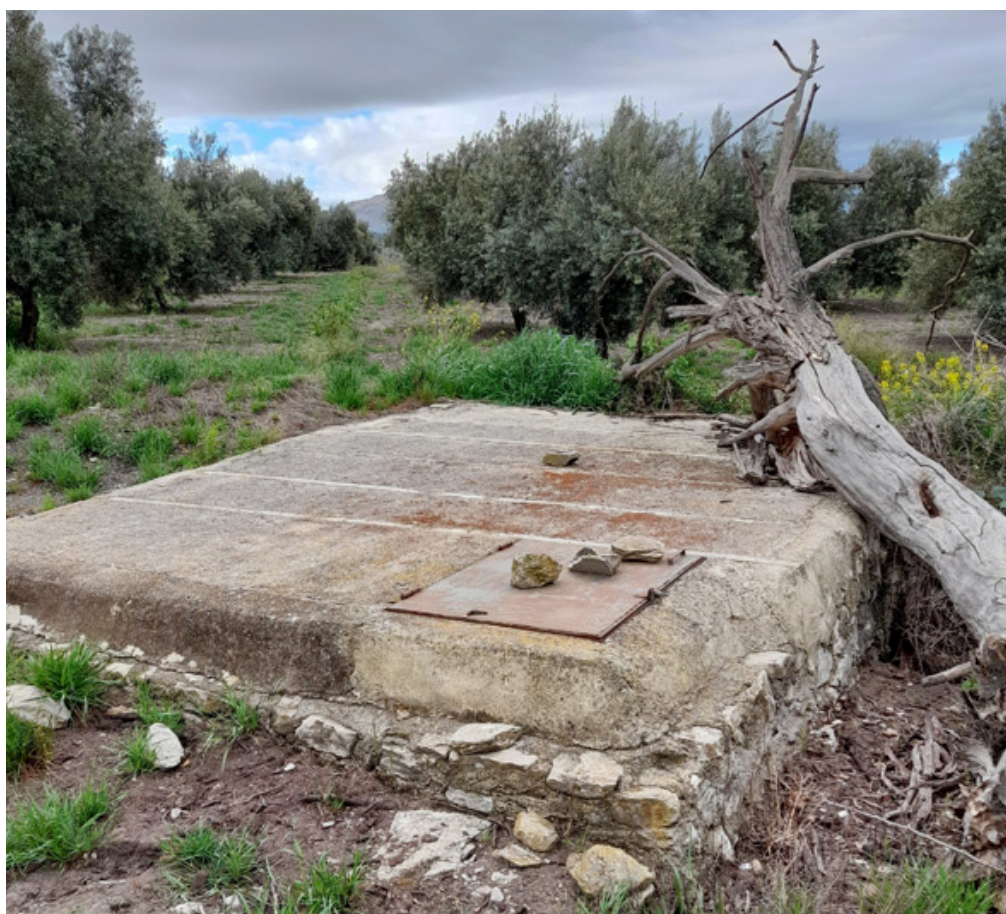
Alberca de agua ahora cerrada como depósito o aljibe (A. Jiménez. Abril de 2021)
