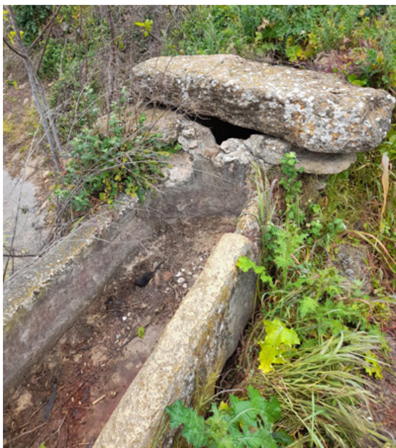
Arqueta de captación de la fuente y la primera pila (A. Jiménez, abril 2021)
