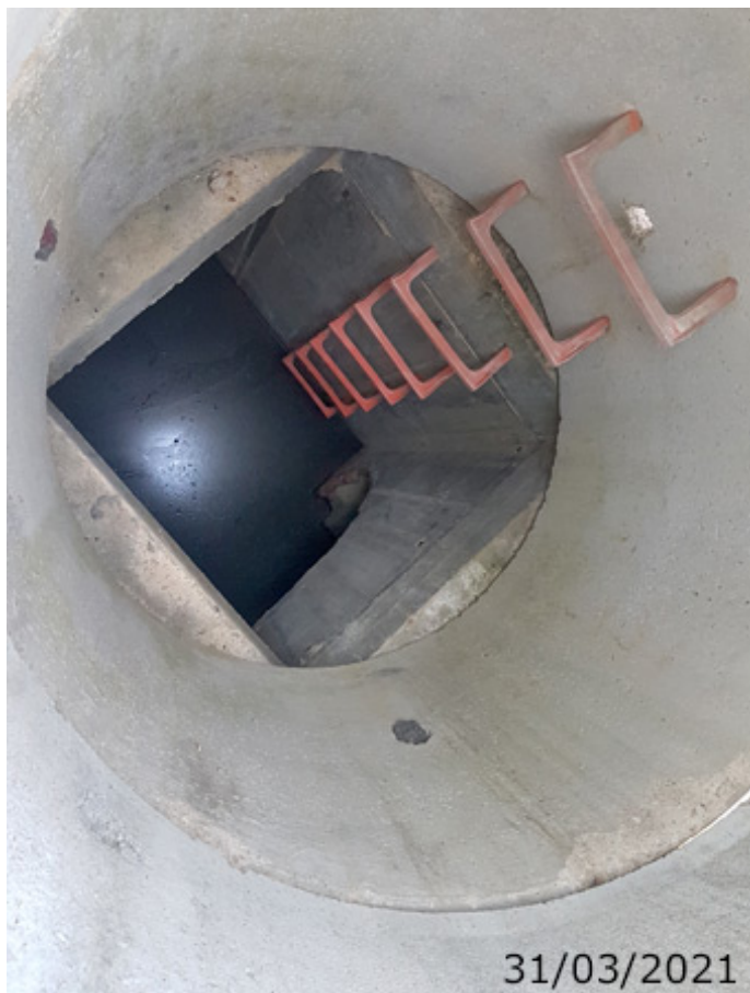
Interior del acceso, abierto, de la galería (A. Ventas, marzo 2021)
