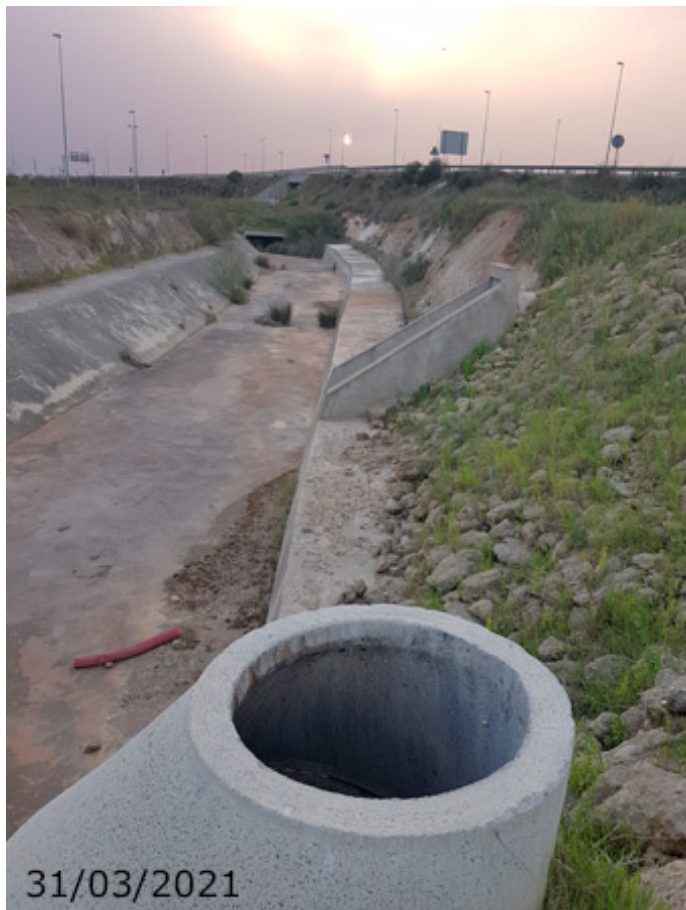
Boca de entrada del acceso a través de una pieza de alcantarillado (A. Ventas, marzo 2021)
