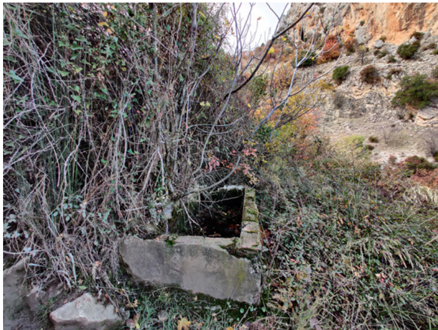
Detalle del pilar principal y la vegetación pujante a sus espaldas (D. Sánchez Garrido, noviembre 2021)
