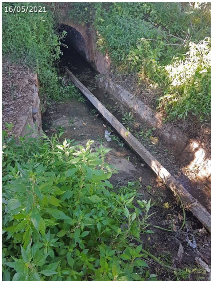
Atarjea que recoge las aguas de las dos conducciones y desaloja el agua al exterior del recinto (A. Ventas, mayo 2021)
