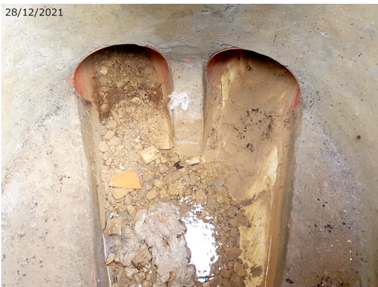
Interior de la alcantarilla con la unión de las dos conducciones de los manantiales de la zona (A. Ventas, diciembre 2021)
