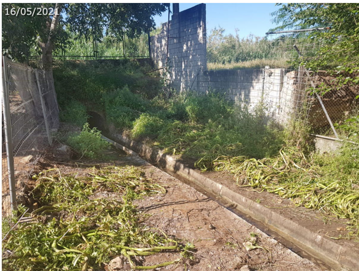
Vista de la atarjea antes de pasar bajo la carretera mediante un antiguo túnel, posiblemente ferroviario (A. Ventas, mayo 2021)
