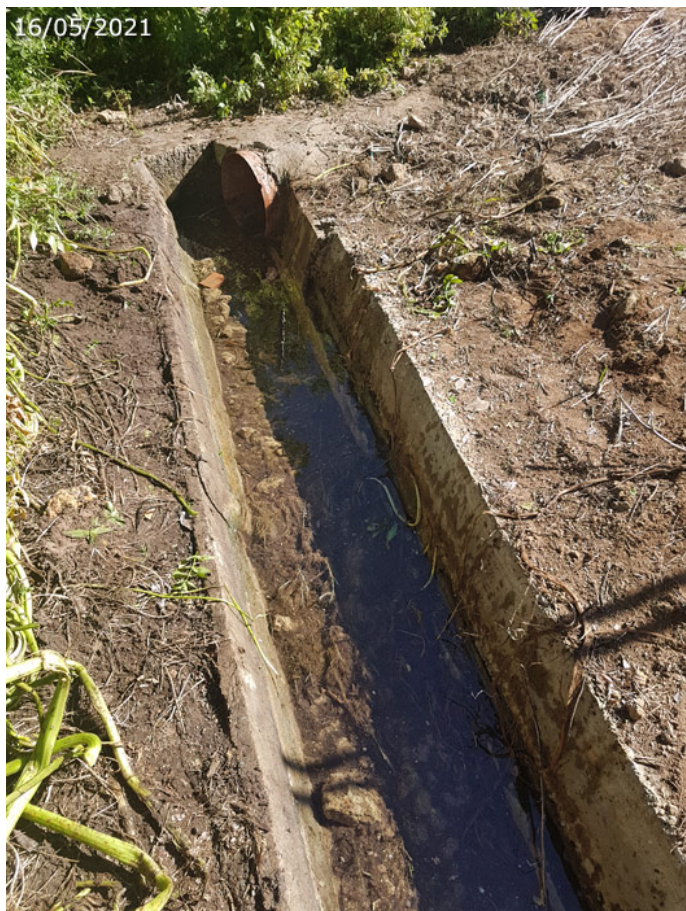
Salida de las aguas del manantial a la atarjea exterior (A. Ventas, mayo 2021)
