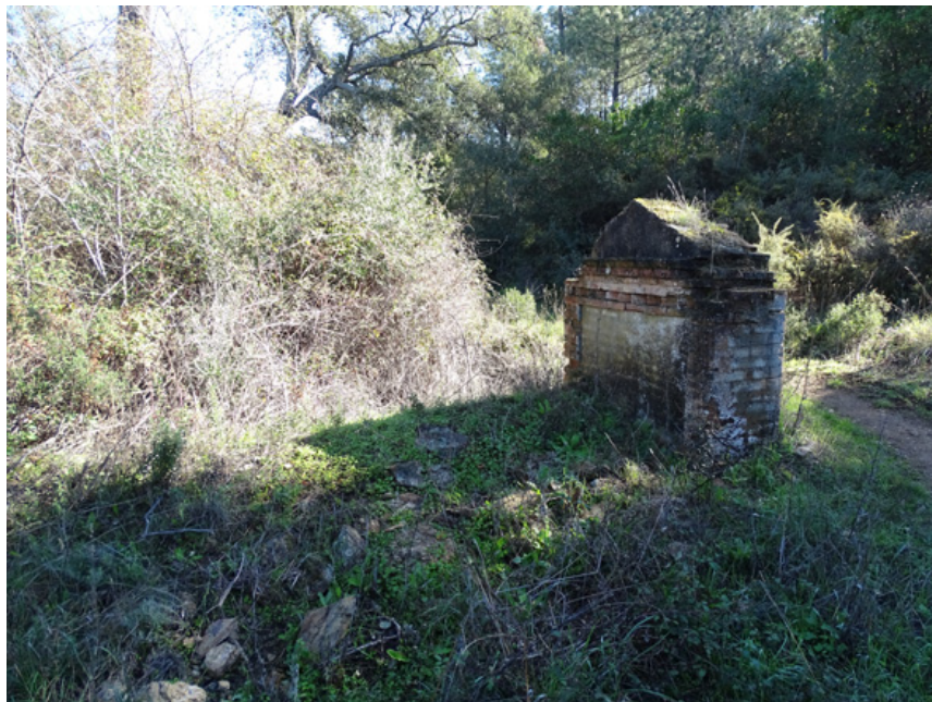
Frontal de la fuente, donde se puede observar piedras de la antigua fuente-lavadero (J. F. Martín Álvarez, enero 2022)
