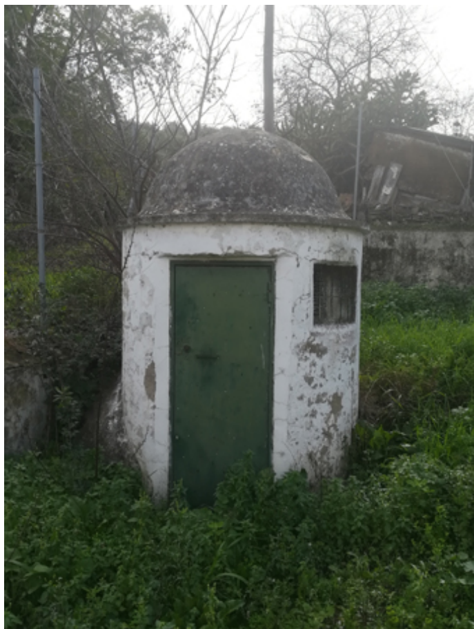
Pozo de acceso de la canalización (J. F. Sánchez Beltrán, enero 2022)
