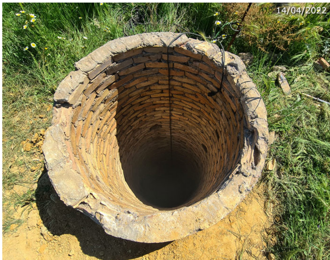
2ª Lumbra, abierta para los trabajos de limpieza (A. Ventas, abril 2022)
