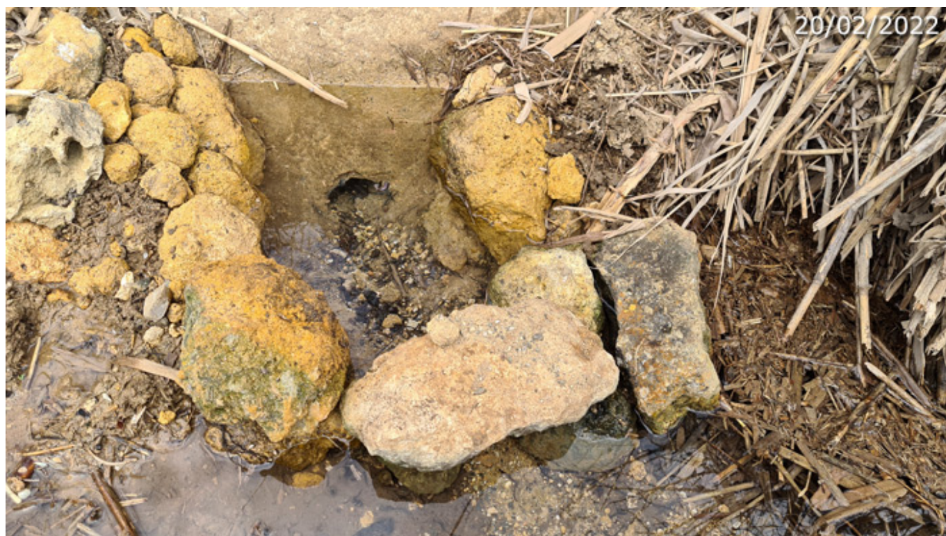
Detalle del interior del pocillo de protección con piedras de albera para la salida de las aguas de la fuente en el canal (A. Ventas, febrero 2022)
