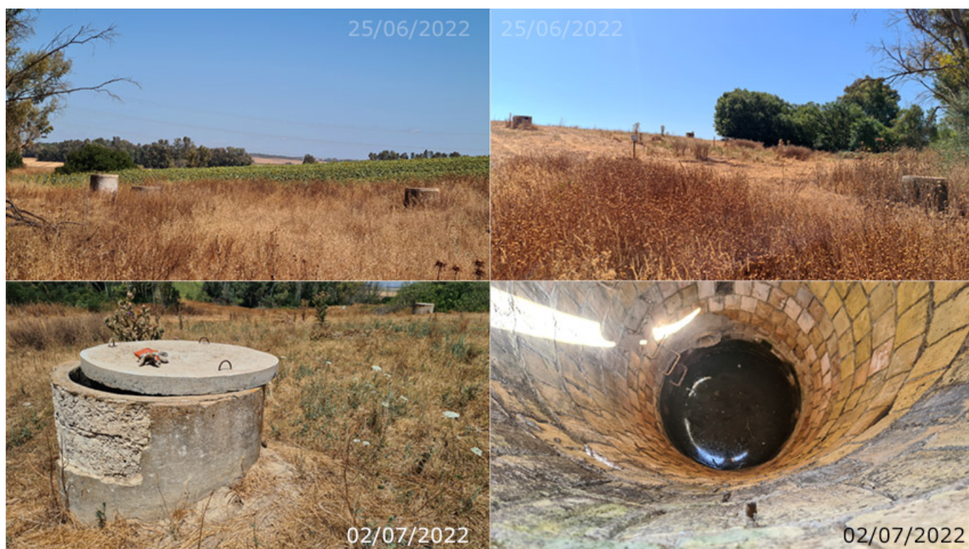
Línea superior de pozos, única que parece mantener agua, aunque de ésta no llegue a la fuente (A. Ventas. Junio y Julio 2022)
