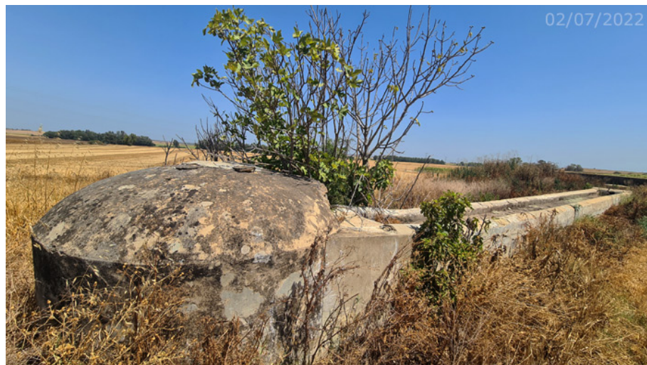
Arqueta de recepción del agua desde el manantial, al que se adosa el abrevadero (A. Ventas, julio 2022)
