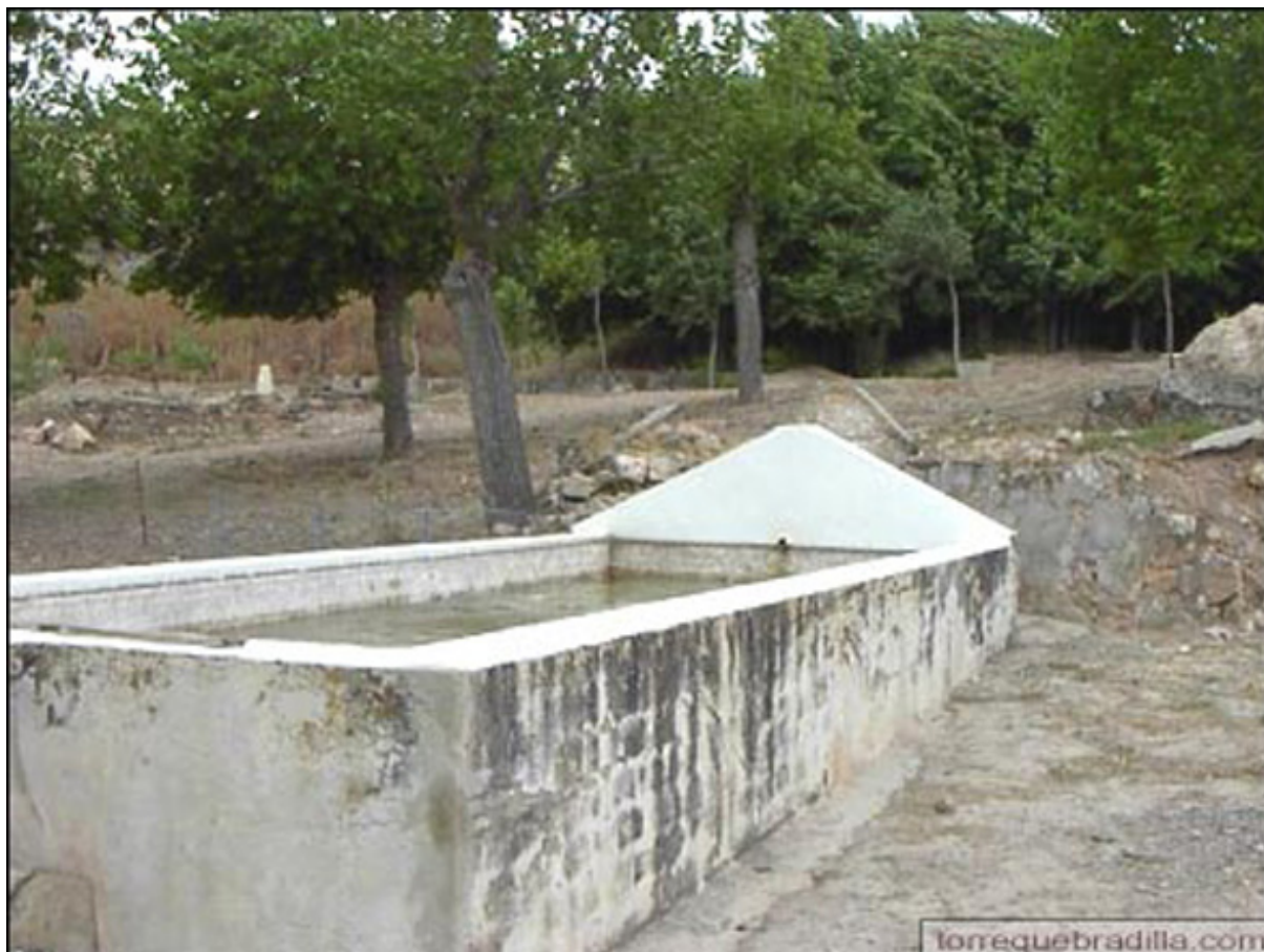
Imagen de cómo era el pilar antes de su remozado (torrequebradilla.com, fecha desconocida)
