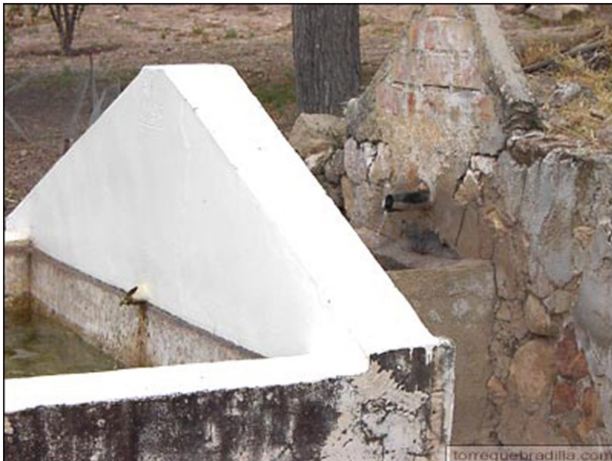
Imagen antigua de la fisonomía antigua de la fuente de la Higuera. Se observan dos frontones triangulares con sendos caños, muy cercanos entre sí (torrequebradilla.com, fecha desconocida)
