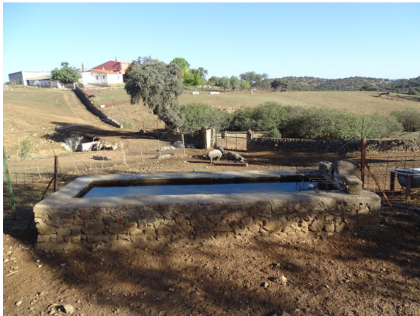
Vista general de la fuente donde al fondo se observa el cortijo Viejo de la Mezquita (J. F. Martín Álvarez, octubre 2022)
