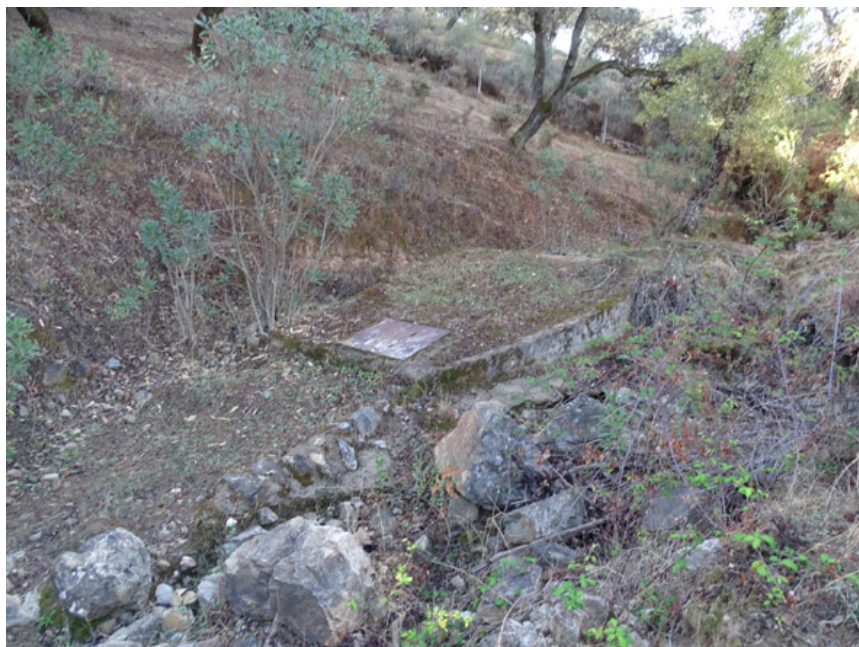
Vista general donde se encuentra el manantial y punto de captación junto al arroyo del Capitán (J. F. Martín Álvarez, octubre 2022)
