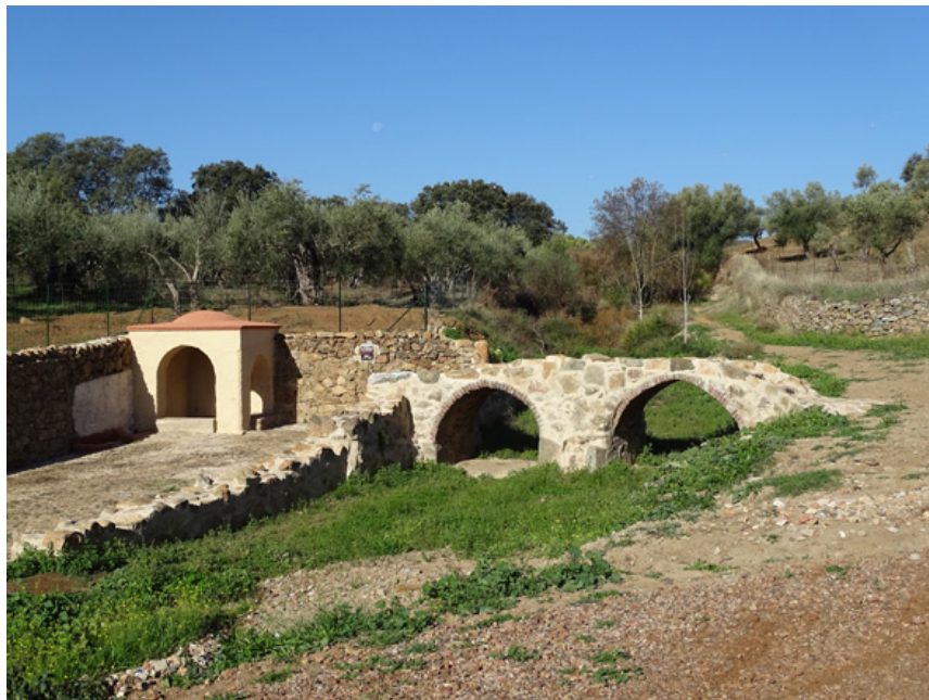
Vista general de la fontana del manantial del Arroyolimón y el puente de los Dos Ojos (J. F. Martín Álvarez, noviembre 2022)
