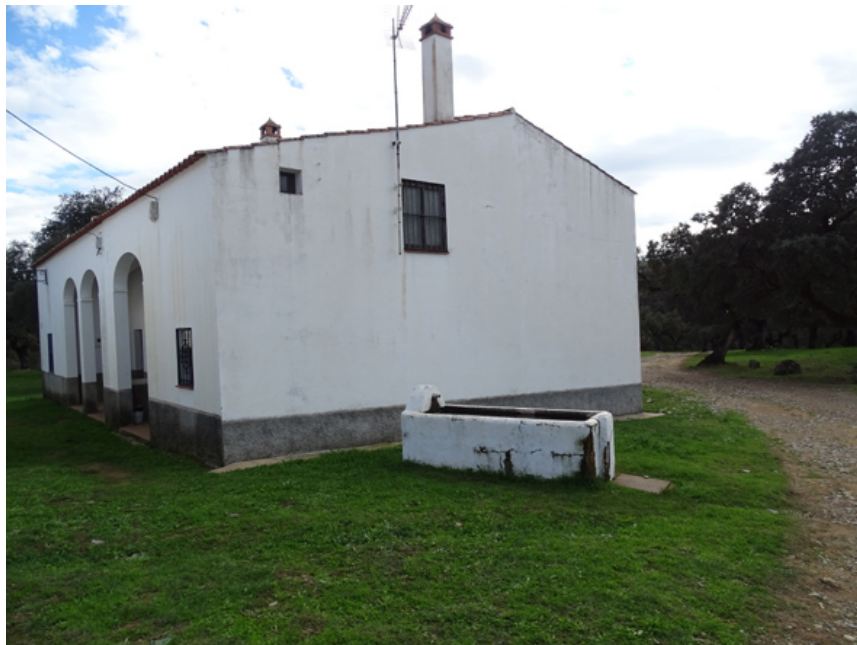
Vista general donde se encuentra el pilar (J. F. Martín Álvarez, diciembre 2022)
