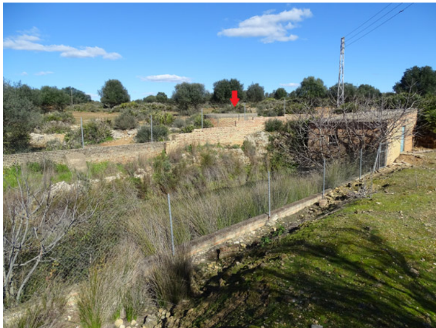
Vista de la fuente (flecha roja), estación de bombeo y alberca excavada en la misma roca (J. F. Martín Álvarez, enero 2023)
