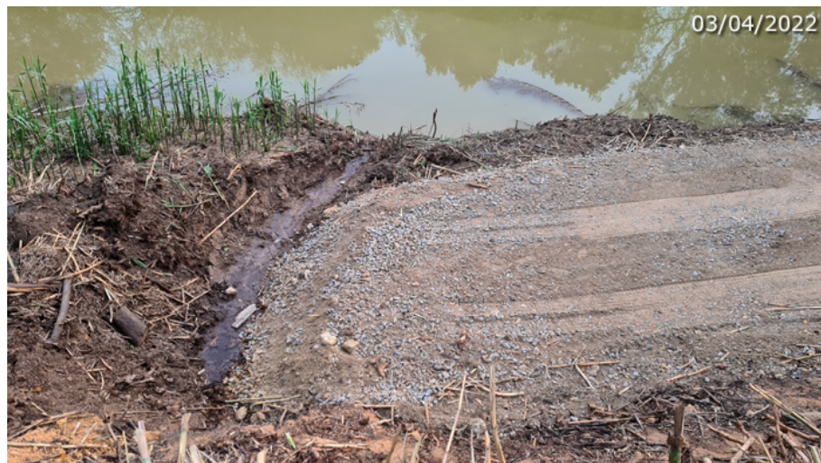
Obras del Antiguo camino de la Huerta de La Peñuela, llegando al manantial (A. Ventas, abril 2022)
