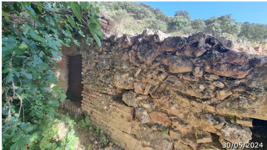
Entrada a la captación del manantial, entre la higuera y el muro de piedras (A. Ventas, mayo 2024)
