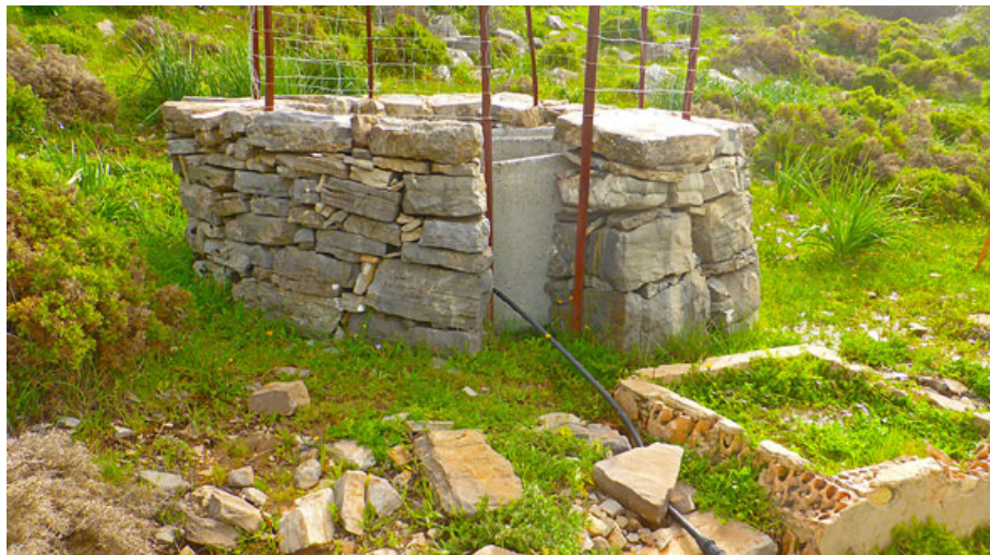
Brocal del pozo que rodea a un cilindro de hormigón prefabricado. Delante un abrevadero muy deteriorado (P. Sánchez Gil, abril 2024)
