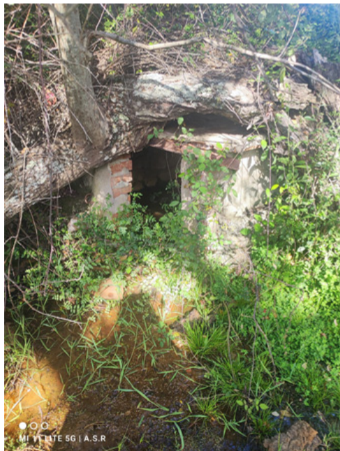
Fuente Las Casillas (A. Sánchez Román, abril 2024)
