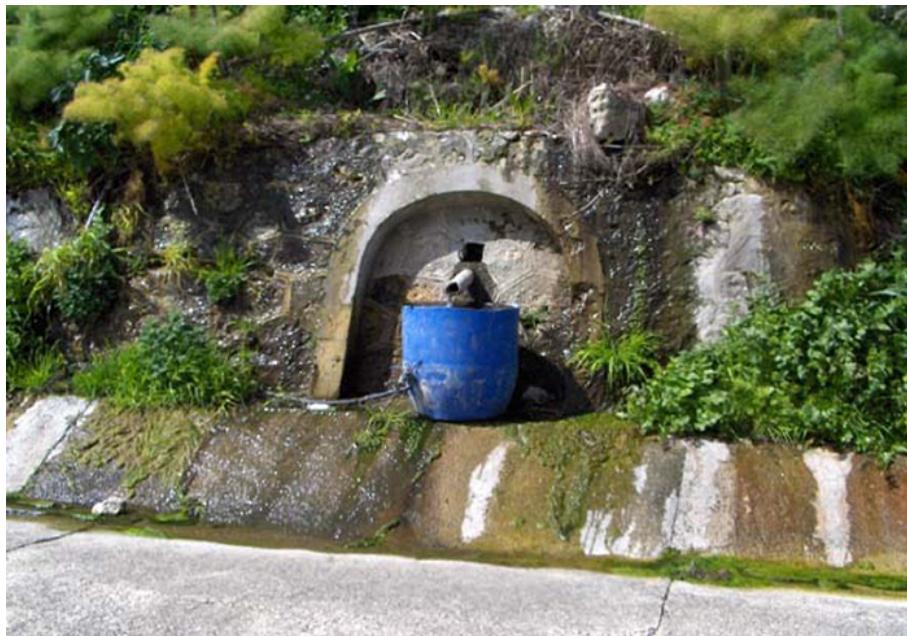
Fuente en años anteriores, mostrando la pared trabajada del talud con los rezumes, así como el caño y su recogida de agua (S. Rodríguez, mayo 2010)
