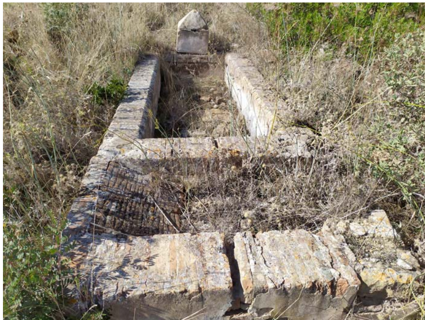
Vista de la fuente, con su abrevadero y lavadero en primer plano ( www.adesealambrrar.com , noviembre 2020)
