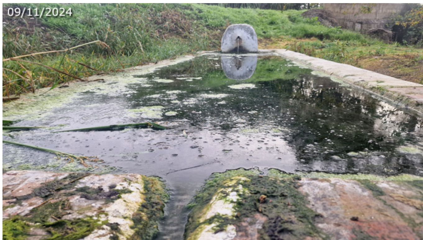
Rebosadero de la fuente, en primer plano, con el caño al fondo (A. Ventas, Noviembre 2024)
