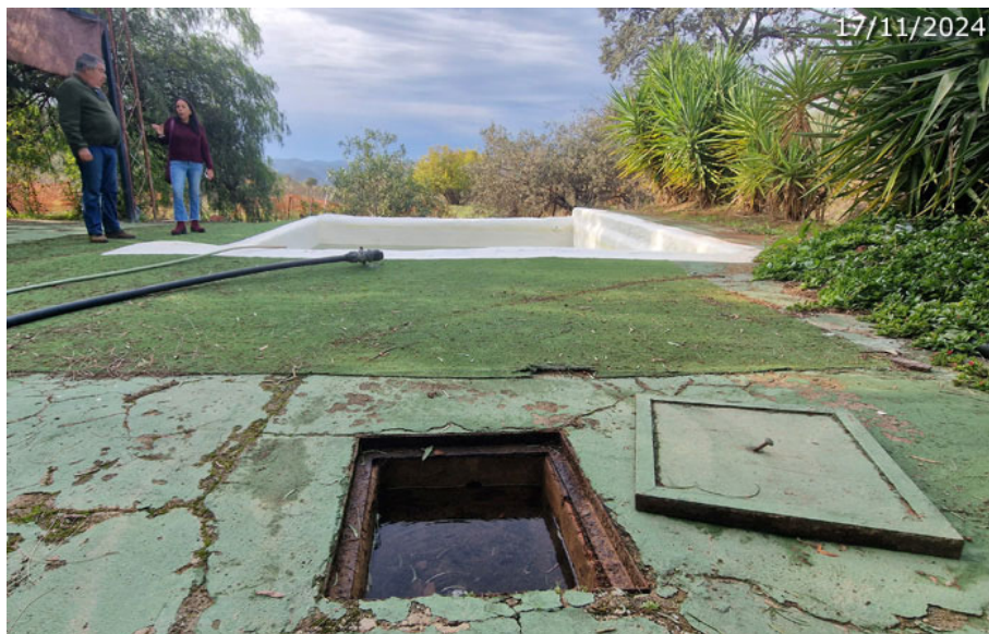
Arqueta y Alberca en el recinto de esparcimiento de la casa (A. Ventas, noviembre 2024)
