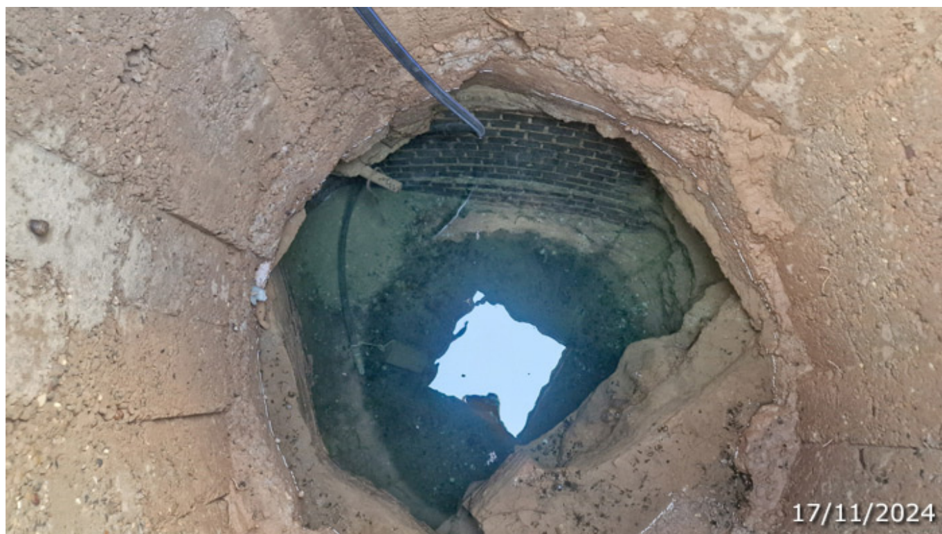
Interior del pozo desde el borde del brocal (A. Ventas, noviembre 2024)
