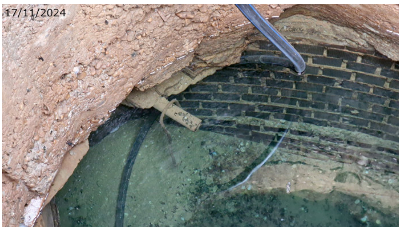
Fondo del pozo mostrando el caño sumergido de abastecimiento para la fuente por gravedad (A. Ventas, noviembre 2024)
