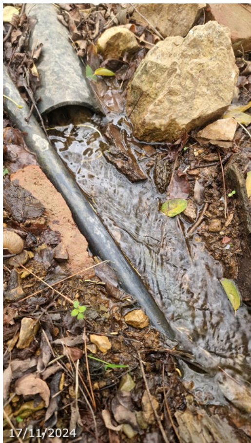
Salida soterrada de las aguas tras el paso del recinto (A. Ventas, noviembre 2024)
