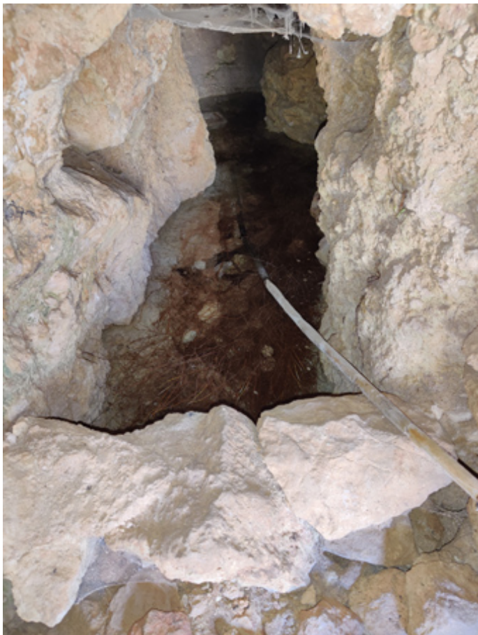
Interior del minado, con una tubería que recoge el agua (D. Sánchez Garrido, marzo 2022)
