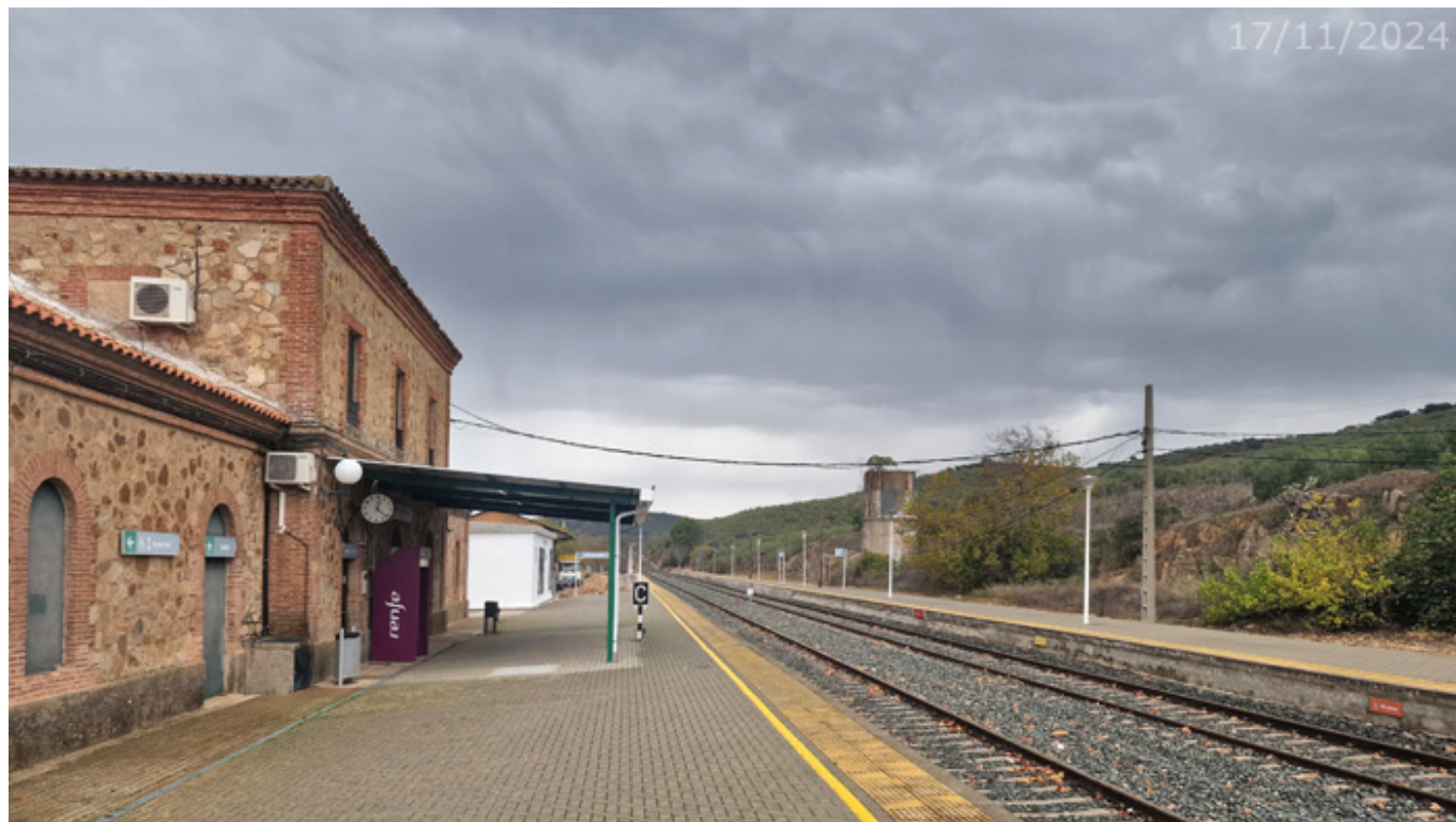
Estación de Guadalcanal, al fondo el depósito y 30 m antes de llegar a él, en línea, la fuente (A. Ventas, noviembre 2024)
