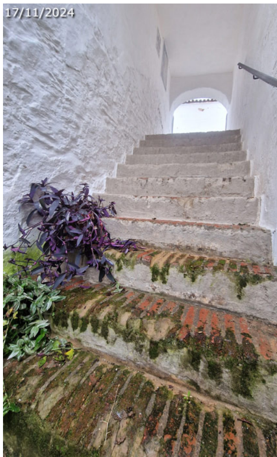
Escaleras de bajada al lavadero desde la C/Pilar (A. Ventas, noviembre 2024)
