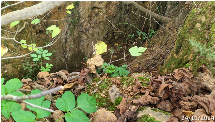
Zanja en su tramo final intuyendo una galería (A. Ventas, noviembre 2024)
