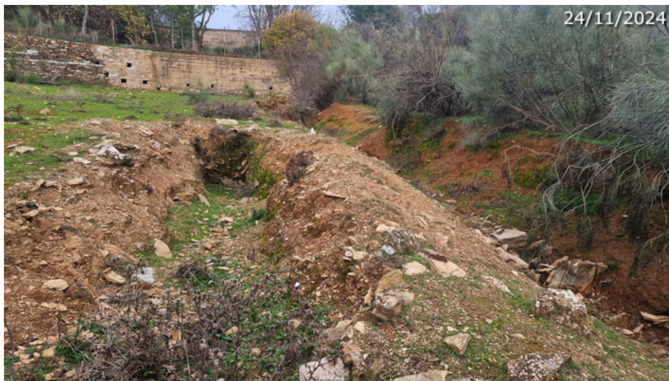
Zanja, posiblemente fallida, para buscar una mina de agua. A su derecha, el cauce seco del arroyo (A. Ventas, noviembre 2024)
