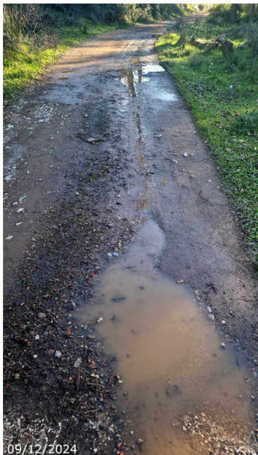
Encharcamientos y regueros de agua en el camino, de surgencias difusas, antes de llegar al manantial (A. Ventas, diciembre 2024)
