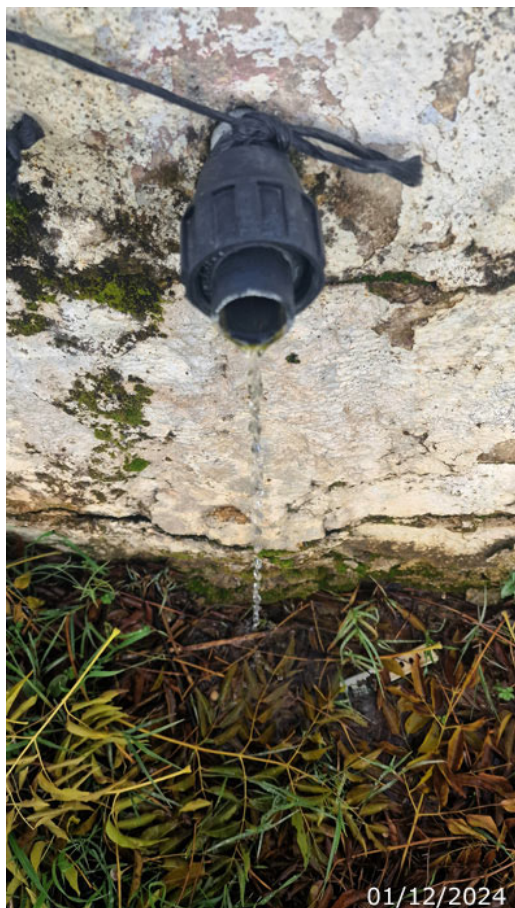
Caño de salida de agua de la pileta triangular, discurriendo a chorro libre (A. Ventas, diciembre 2024)
