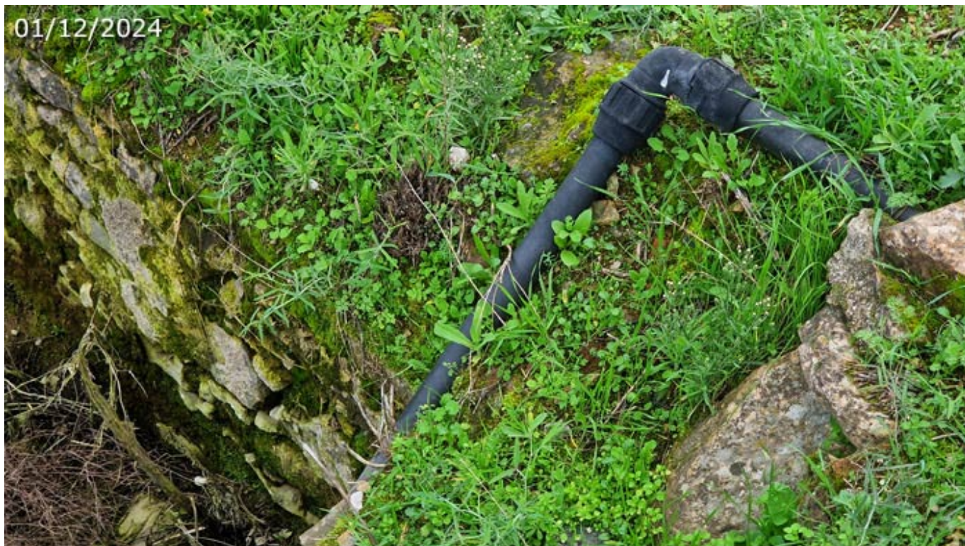
Conducción acodada con dirección perpendicular al camino, posiblemente buscando el zarzal del otro lado (A. Ventas, diciembre 2024)
