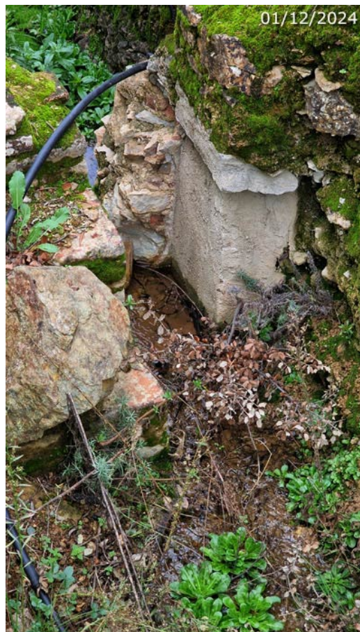
Restos de lo que podría ser una compuerta para represar el agua en la zanja a cielo abierto (A. Ventas, diciembre 2024)
