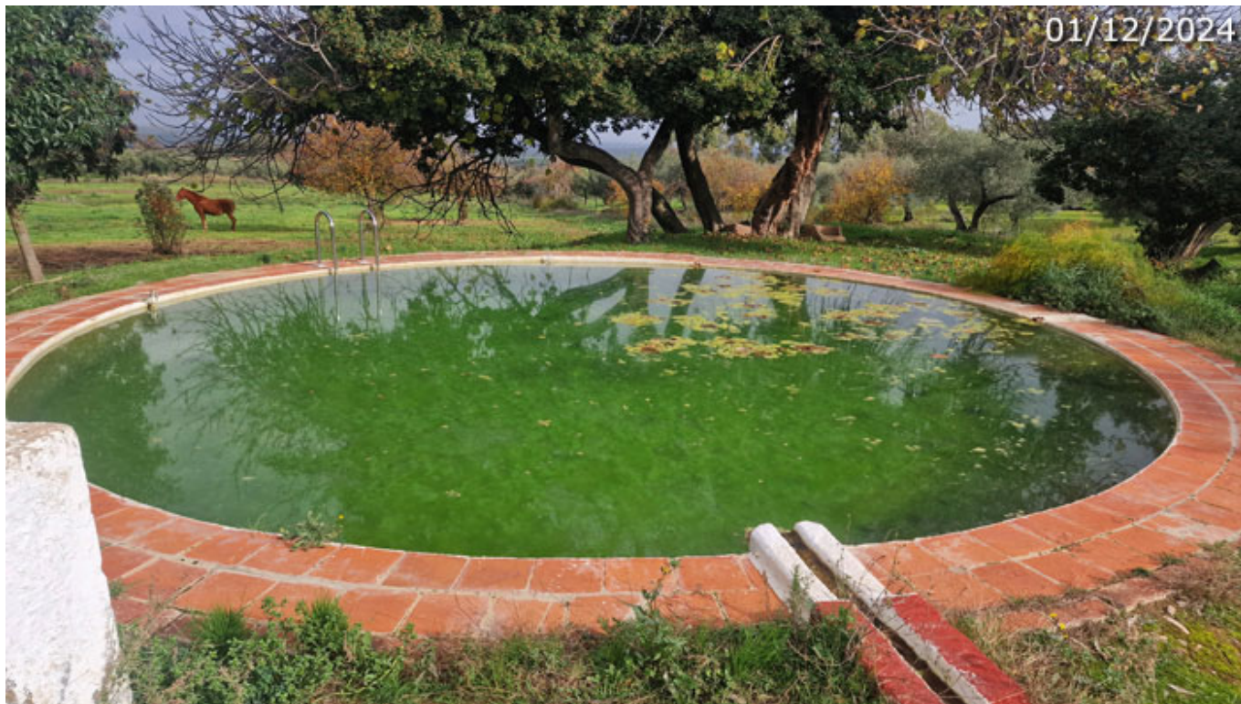
Alberca, con parte de la pila sobreelavada a la izquierda y la atarjea de entrada de agua desde la fuente a la derecha (A. Ventas, diciembre 2024)
