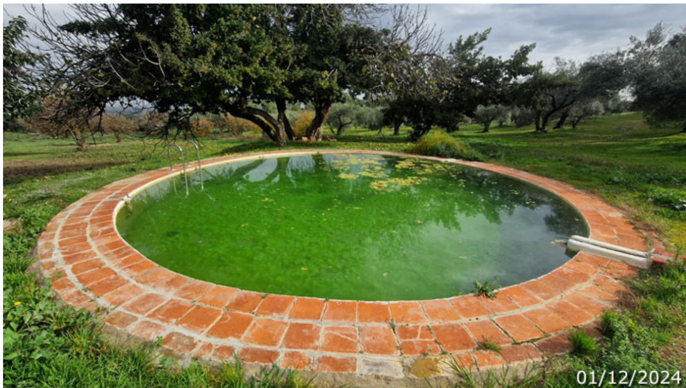
Visión general de la alberca, con la escalera de acceso a la izquierda y el rebosado a su derecha (A. Ventas, diciembre 2024)
