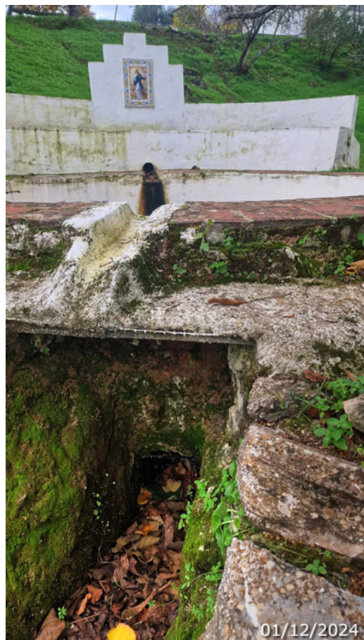
Atarjea para la salida superior del agua de la alberca y compuerta inferior de vaciado, al fondo la fuente (A. Ventas, diciembre 2024)
