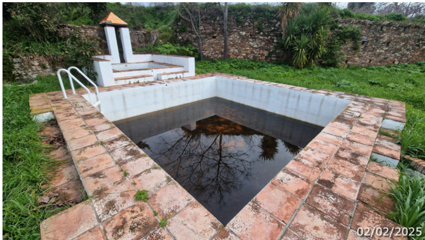
Piscinas en primer plano, pared de la alberca al fondo y pileta para recoger las aguas del rebosadero a la izquierda (A. Ventas, febrero 2025)
