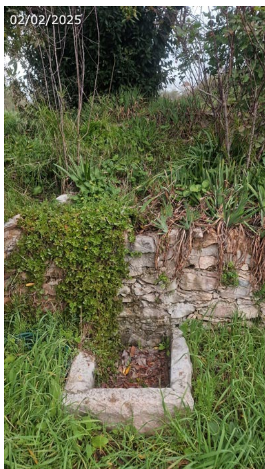
Pileta cuadrada en el suelo que recogería las aguas del rebosadero, en la parte superior (A. Ventas, febrero 2025)
