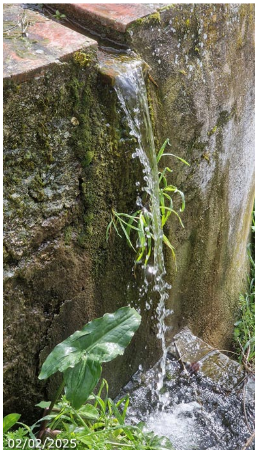
Agua cayendo por el rebosadero de la alberca a la pileta, abajo (A. Ventas, febrero 2025)
