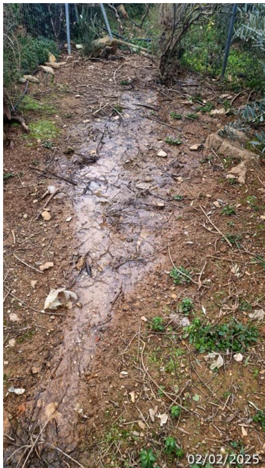
Reguero de agua al final de la huerta tras la salida del canalón de PVC (A. Ventas, febrero 2025)
