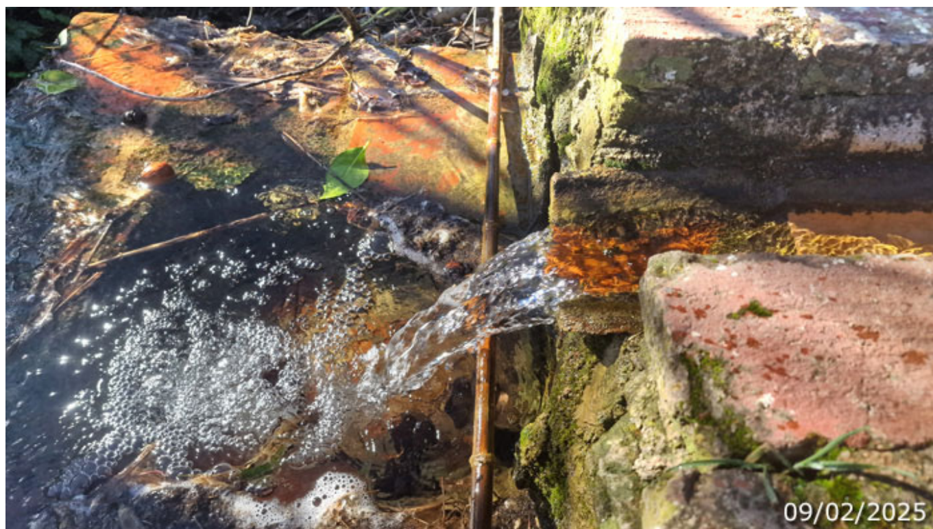
Rebosadero de tejas de la alberca (A. Ventas, febrero 2025)
