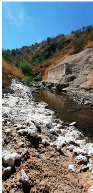
Nacimiento del Arroyo de la Salina, muro de hormigón en el nacimiento (A. Serna Barquero, septiembre 2022)
