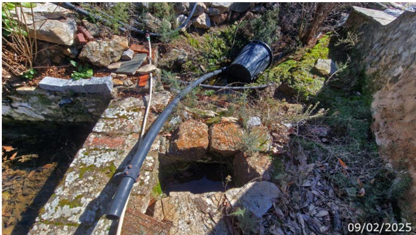
Arqueta en el suelo entre la fuente y la alberca antigua con el caño seco, en la esquina, encastrado en la pared de la arqueta de captación del manantial (A. Ventas, febrero 2025)
